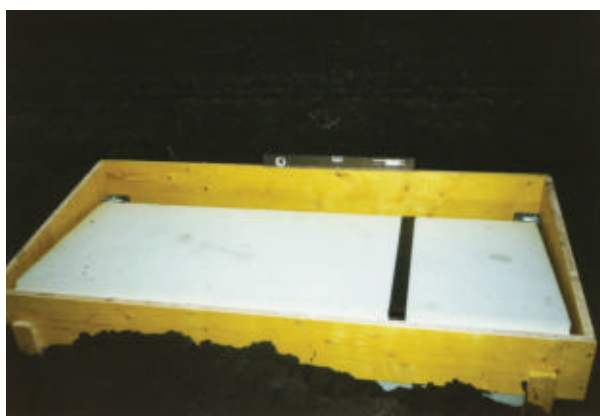
Abb. 2 Bau des Witterungsschutzes für die betriebsfertigen Anlagen
