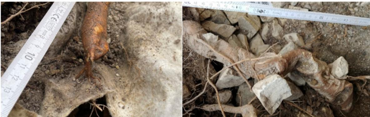
Abbildung 7: Wurzel ausbreitung im Bereich einer nicht optimal hergestellten Baumscheibe mit Vlies und Belüftungs- / Verteilschicht (links Ausbreitung durch das Vlies, rechts Ausbreitung durch die Belüftungs- und Verteilschicht)
