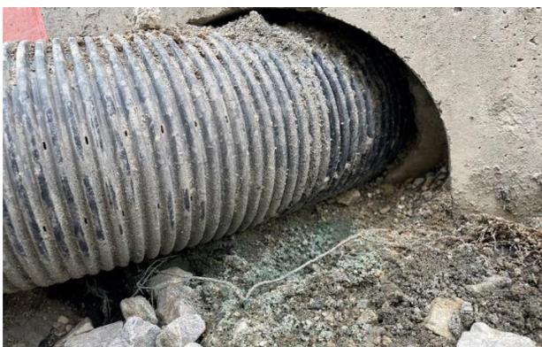
Abbildung 6: Beispiel eines undicht hergestellten Anschlusses zwischen Verteilrohr und Einlaufschacht
