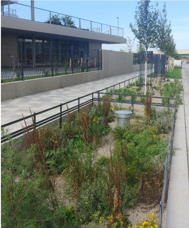
Abbildung 4: Kombination eines Bodenfilterbeckens mit biodiverser Staudenbepflanzung mit dem Schwammstadtsystem für Bäume in der Seestadt in Wien
