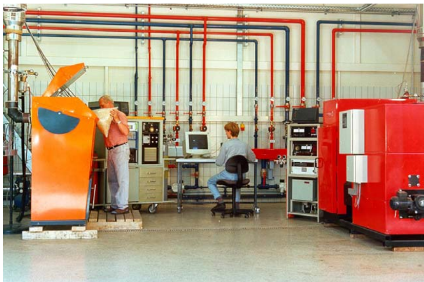
Bild 20: Prüfstand für biogene Feuerungen an der BLT
