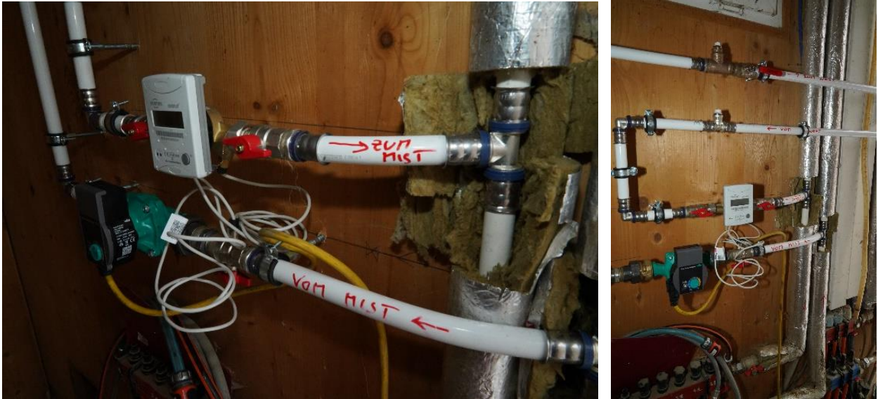
Abbildung 4: Wasserleitungen von bzw. zu Mistreaktor und Ferkelnest.
