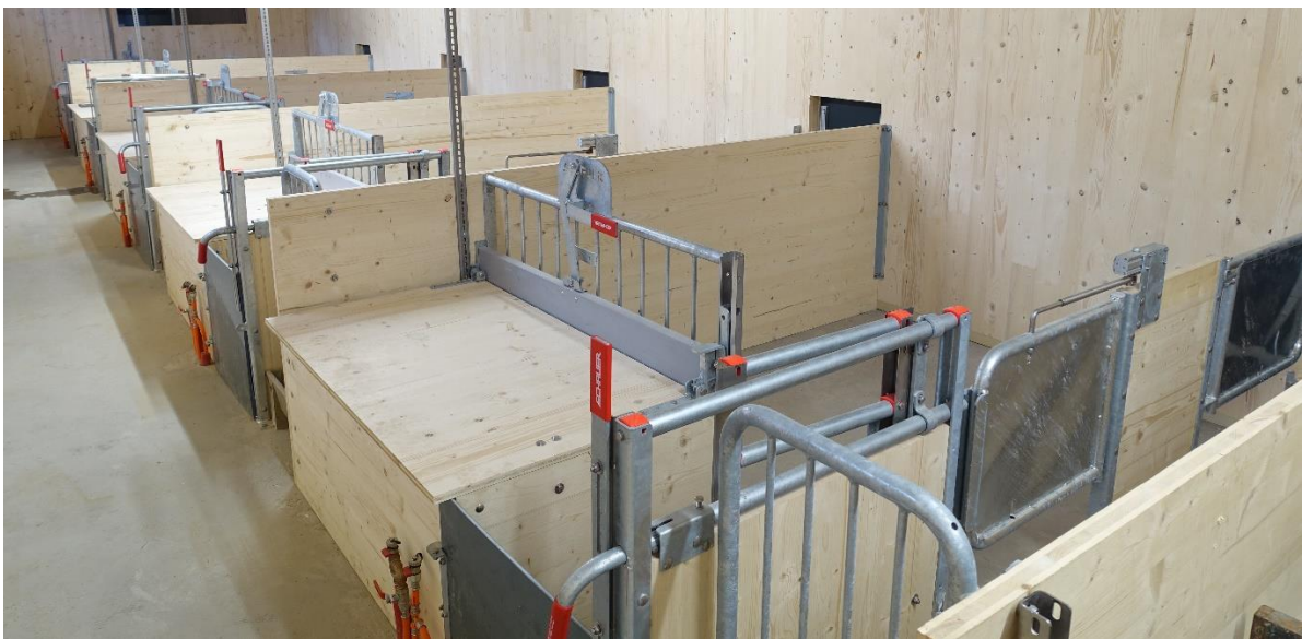
Abbildung 2: Innere Buchtstruktur mit Ferkelnestern im Modularen Abferkelstall
