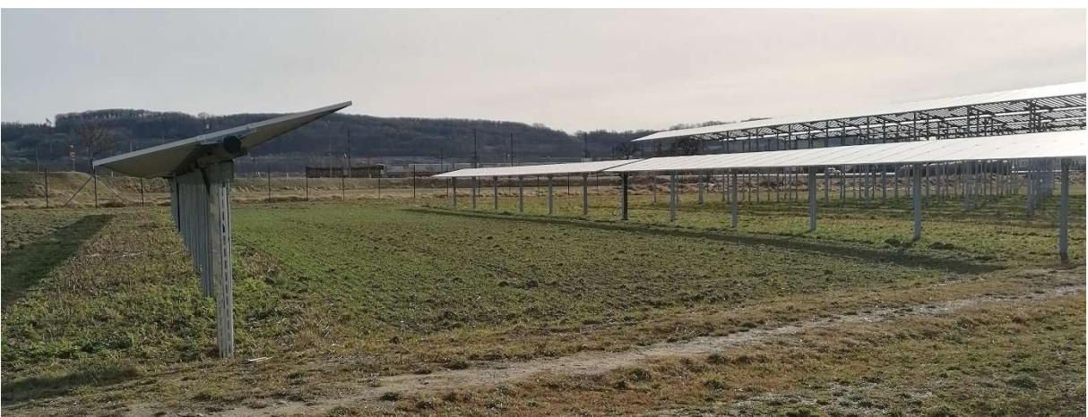
Abbildung 3: Nachgeführte Agri-PV-Anlage mit Ackerfläche (eigene Aufnahme)
