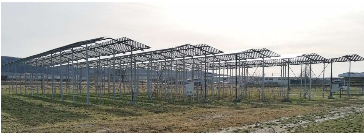
Abbildung 5: hochaufgeständerte Agri-PV-Anlage mit Dauerkulturen (eigene Aufnahme)
