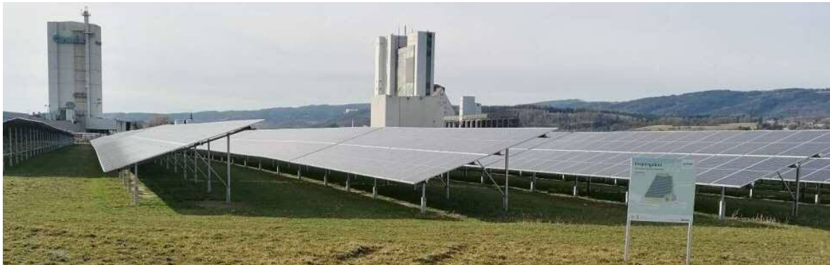
Abbildung 3: Klassische Agri-PV-Anlage mit Grünlandnutzung (Pfusterschmid und Holzweber 2022)
