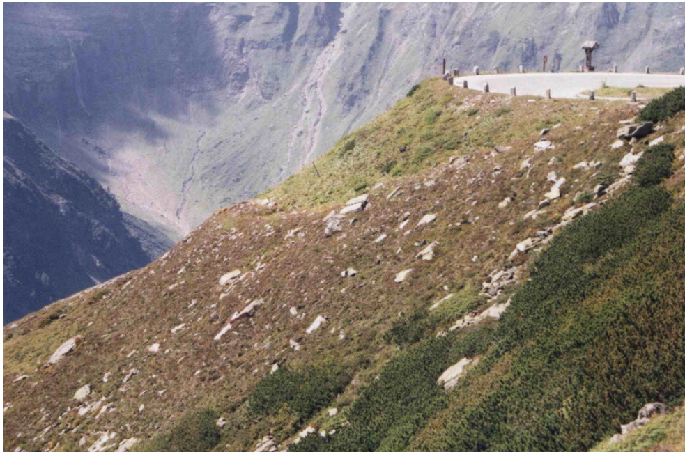
Abbildung 3: Blick auf die Straßenböschung an der Hexenküche – Großglockner-Hochalpenstraße / Salzburg
