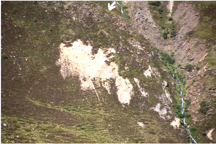
Abbildung 65: Ansicht der Erosion im Sellrain vom Gegenhang; es ist deutlich der über der Erosionszone liegende, nach rechts unten verlaufende Wall zu erkennen (s. Pfeil), der den Auslöser für diesen massiven Bodenabtrag darstellt.
