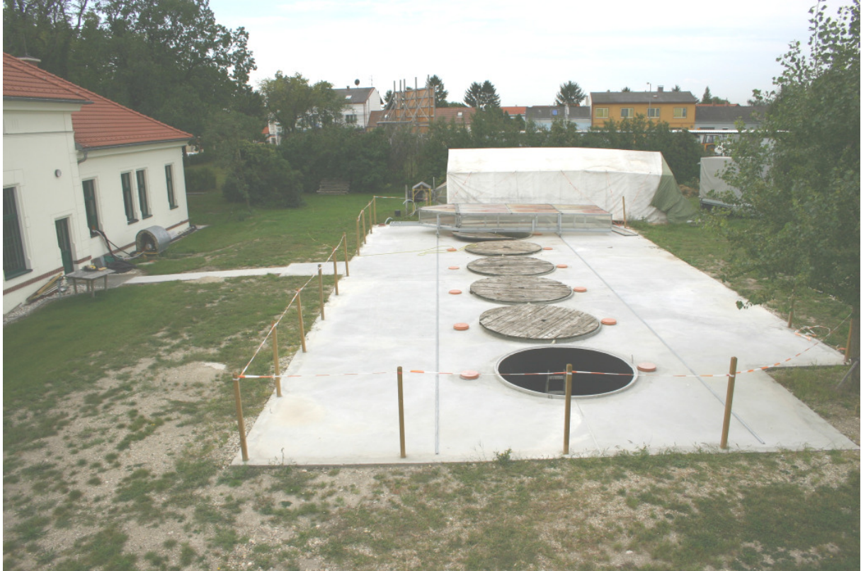
Anhang-Foto F.11. Versuchsanlage in Groß-Enzersdorf nach den Erneuerungsarbeiten im Herbst 2005 (Versuchsfläche wurde betonierte und sechster Versuchsbehälter wurde gebaut)
