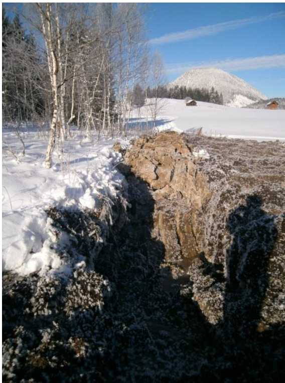
Hochegger, 2013: Einbau Lehm
