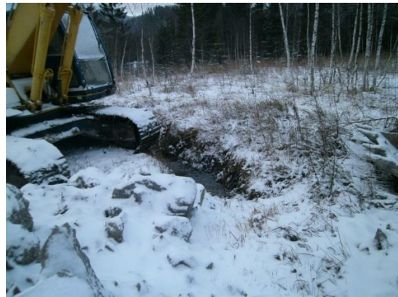
Hochegger, K., 2013: Blick auf offenen Graben
