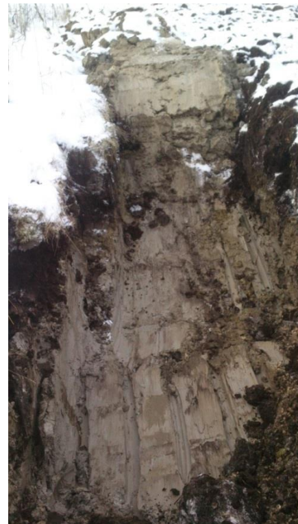
Lehm am Grabenboden zur Verbindung des neu eingebauten Walls
