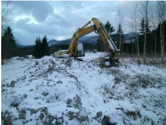
Hochegger K.,2013: Bauarbeiten mit Bagger
