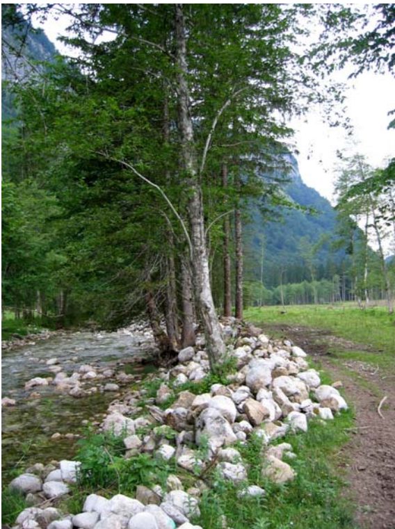
Abb. 5.3: Einer der beiden aufgeschütteten Steinwälle entlang des Rettenbaches
