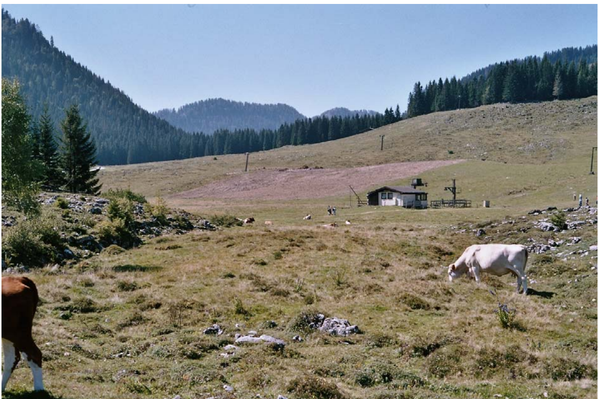
19) Frisch planiertes Gelände des „Funparks“ zwischen 1er (rechts im Bild) und 9er Lift (links im Bild) auf der Großlienbachalm 7. 9. 2004
