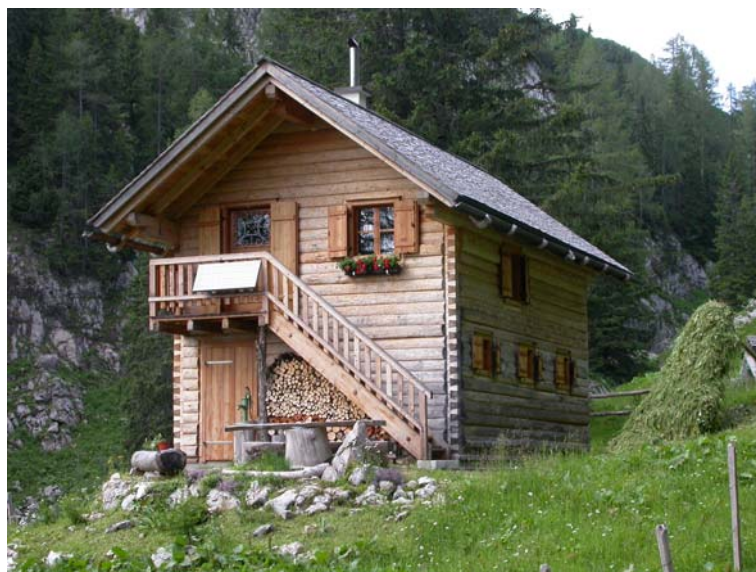
Abb.31: Das im Jahr 2000 neu errichtete Almgebäude der Bärenkogelalm.
