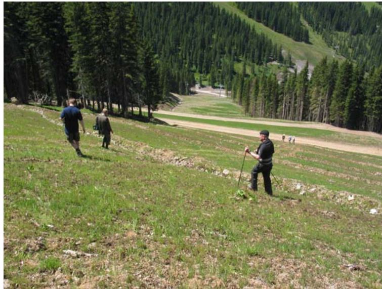
Abb.21: Im Almbereich wurde ein Hang für eine Schiabfahrt geplant. Das Oberflächenwasser, welches nicht versickert, muss mittels breiter Quergräben in den angrenzenden Wald abgeleitet werden. (Foto Legner)
