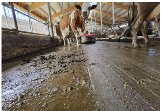
Abbildung 4: Auf unprofilierten Betonoberflächen räumt der Sammelroboter besser als ein Mistschieber. Wichtig ist allerdings, dass kein „Sumpf“ auf den Laufgängen entsteht. Dies lässt sich mit einer guten Routenwahl einfach verhindern.
